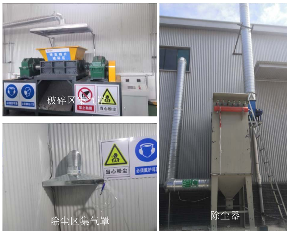
图 3-1 项目除尘设备及排气筒照片
