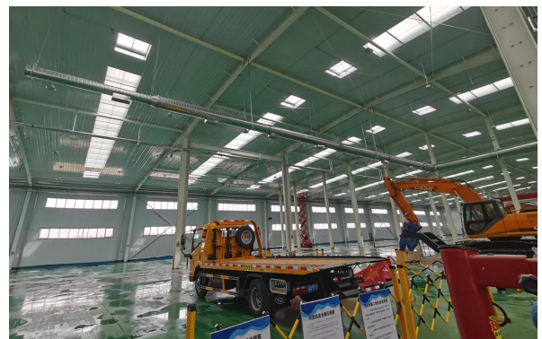
大力机、撕裂机区域集气管道
