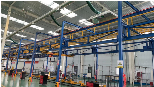
拆解线集气罩及管道
