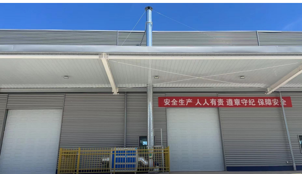
活性炭吸附装置排气筒及监测平台
